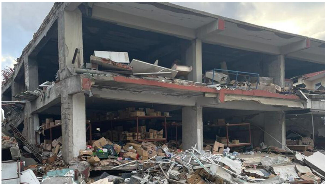
Vom Erdbeben verwüstetes Gebäude in Gaziantep, Türkei (Bild: AVC)
