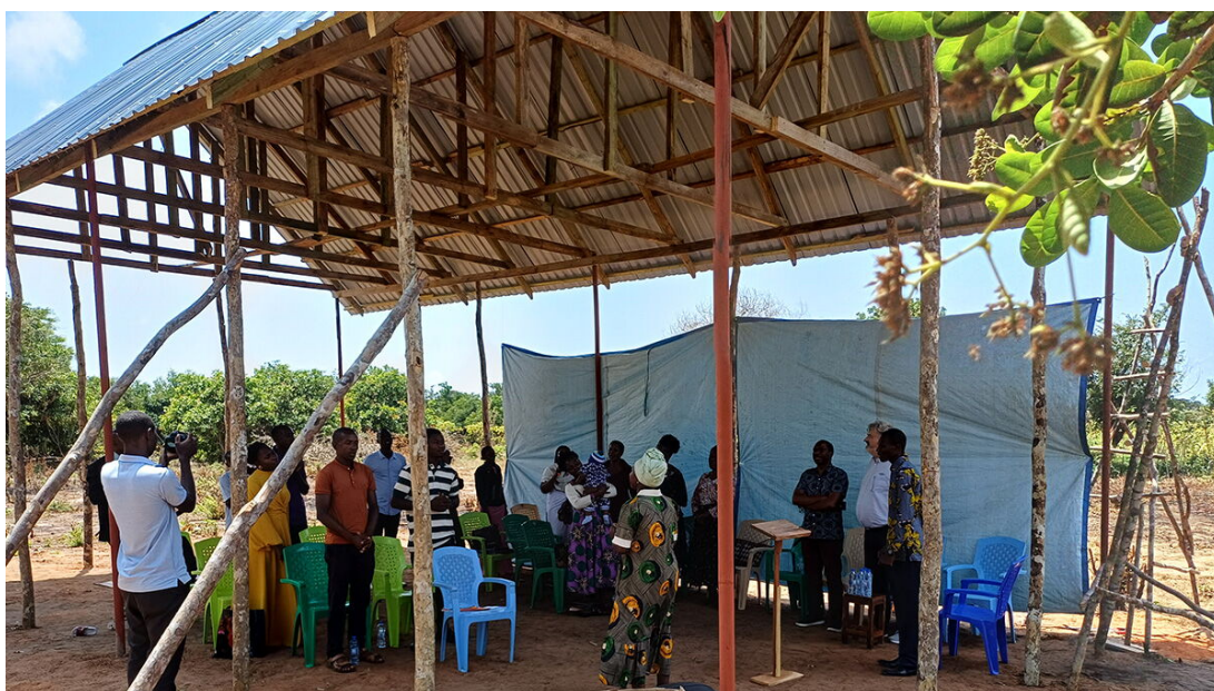
Wie hier üblich, wird erst das Dach bebaut und dann mit Wänden ergänzt (Bild: AVC/BFP-Global)
